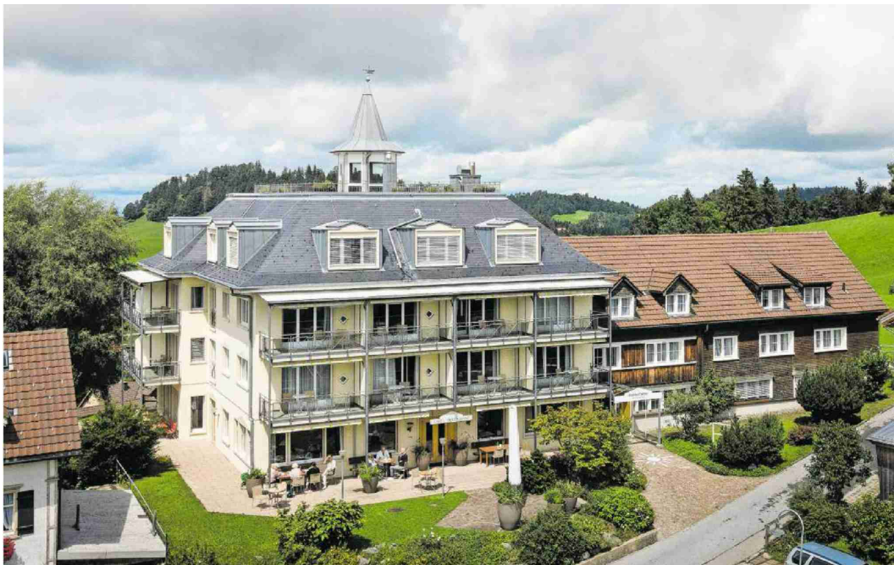
Das neue Biomedical Health Center von Thomas Rau steht an bester Panoramalage in Schwendbrunn.
